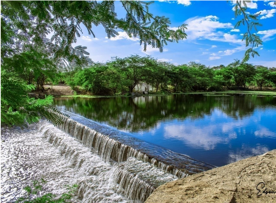
Figura 40. Barragem do Fomento que corta a EAIP
